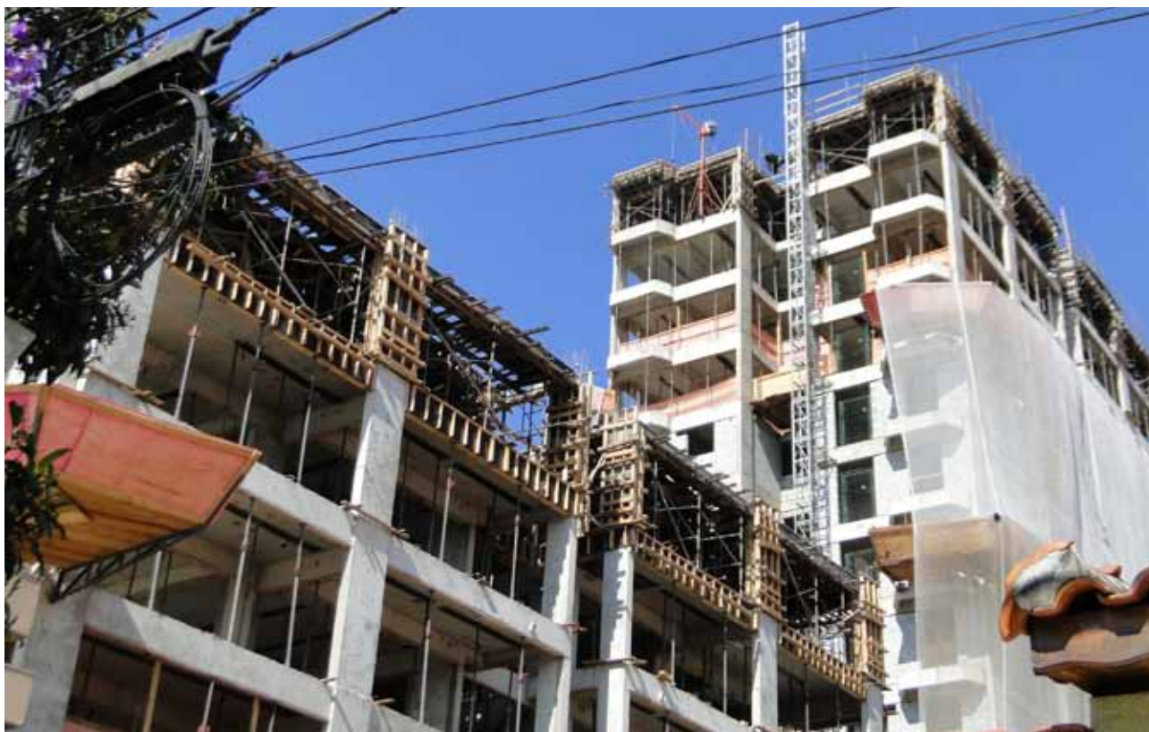
Obra do Residencial Classic MBigucci, no bairro Rudge Ramos em São Bernardo do Campo.
