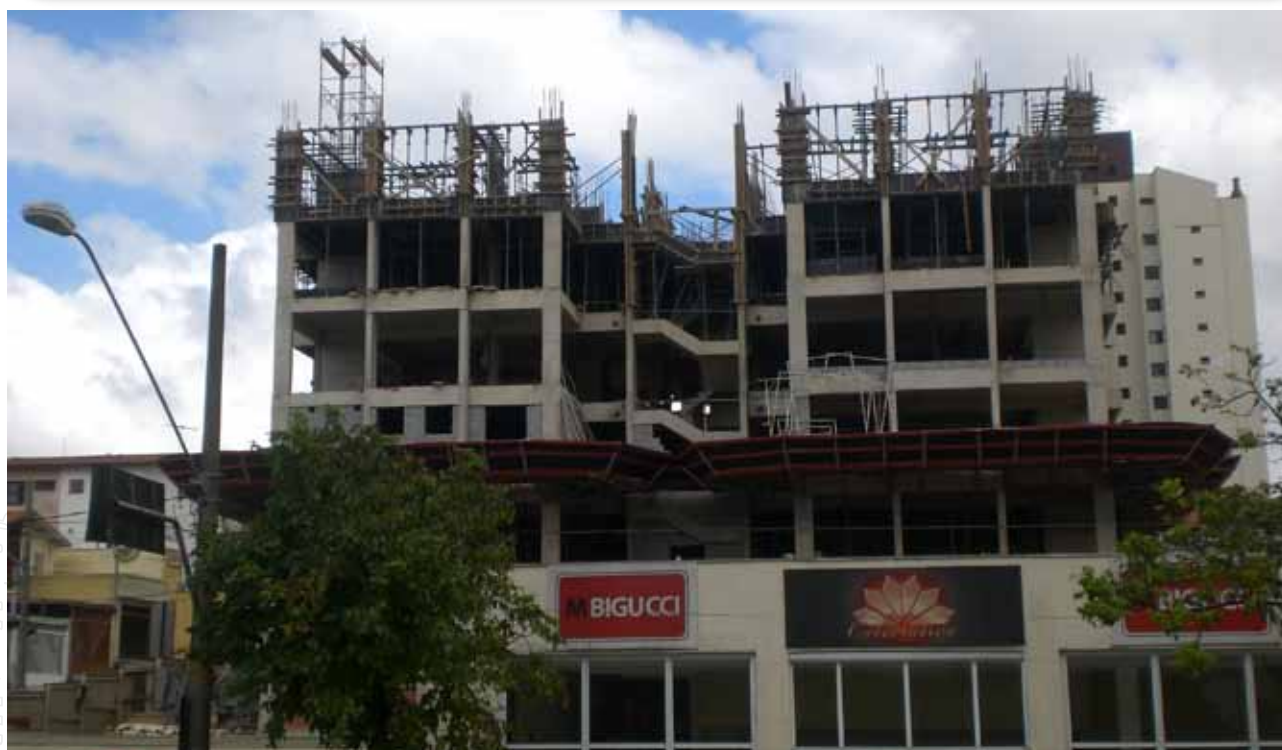
Obra do condomínio Celebration MBigucci, construída no bairro de Rudge Ramos, em São Bernardo do Campo - SP
